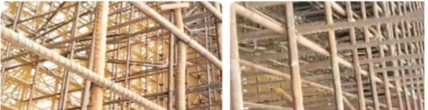
Proyek Jembatan Gantung
