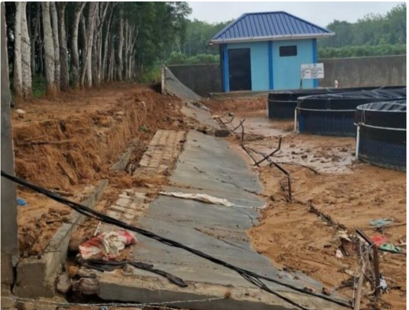
Pagar pembatas Balai Benih Ikan (BBI) Air Tawar di Mesuji -Bukoposo Roboh
