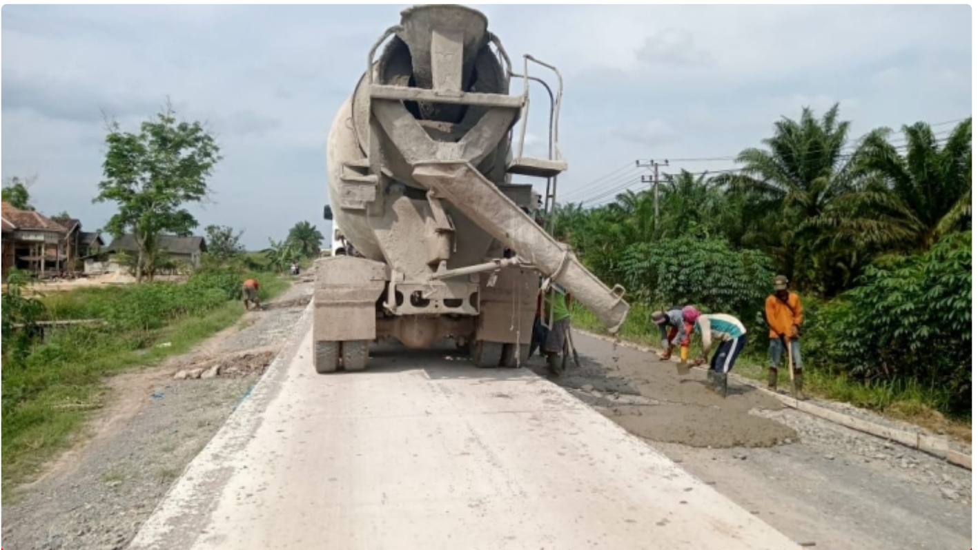
Bangun Jalan Rigid Beton KTM Wonosari
